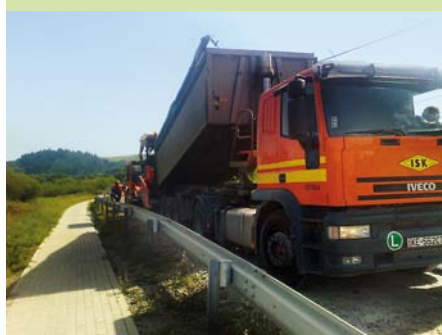
Nové asfaltové vrstvy.
