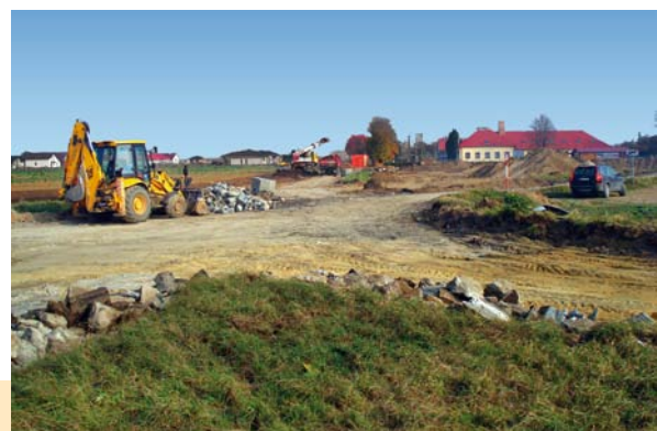
Rozbehnuté práce na kruhovej križovatke pri Senici.
