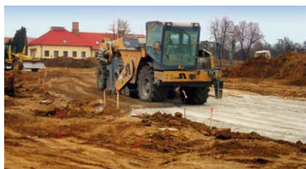
Vylepšenie zemnej pláne cementom, pomocou zemnej frézy.
