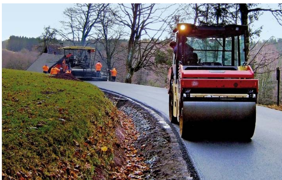
Modernizace přístupových komunikací k hraničnímu přechodu s Polskem Olešnice v Orlických horách (provaz Hradec Králové).
