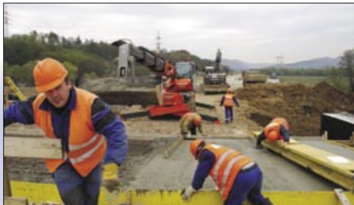
Betónovanie na moste 216, rýchlostná cesta R1 Žarnovica – Šášovské Podhradie.
