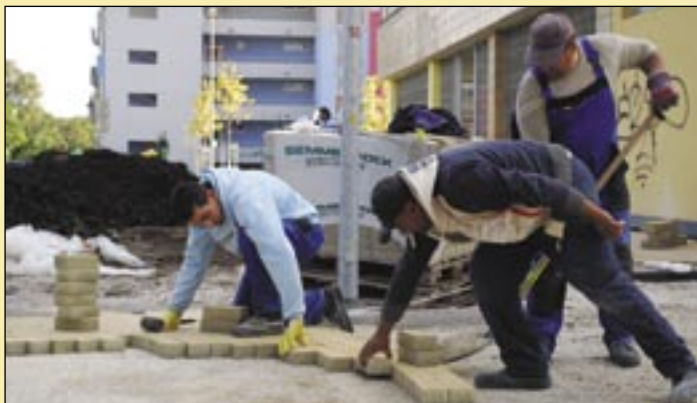
Pokládka dlažby v rámci humanizácie sídliska Prednádražie, Trnava.
