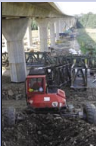
Finiš prác pod mostom 201 na diaľnici Bělotín – Hladké Životice.
