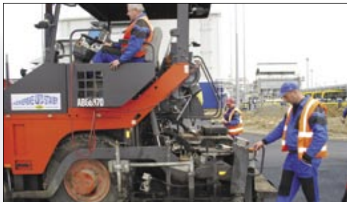
Asfaltovanie v areáli kompresorovne zemného plynu vo Veľkých Kapušanoch.
