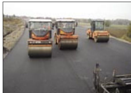
Nové asfaltové vrstvy na obchvatu Příboru, provoz Znojmo.
