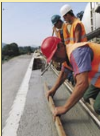
Betónovanie oporného múra na R1 pri Žiari nad Hronom.
