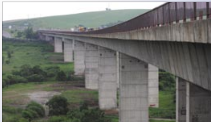
Most Hybica na diaľnici D1, vysoký až 24 metrov, počas opravy.
