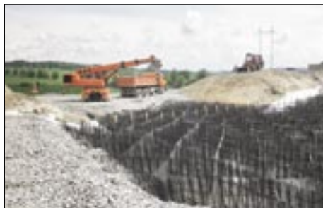
Unikátní geobuňková struktura na úseku Příseka – Brtnice, provoz Jihlava.
