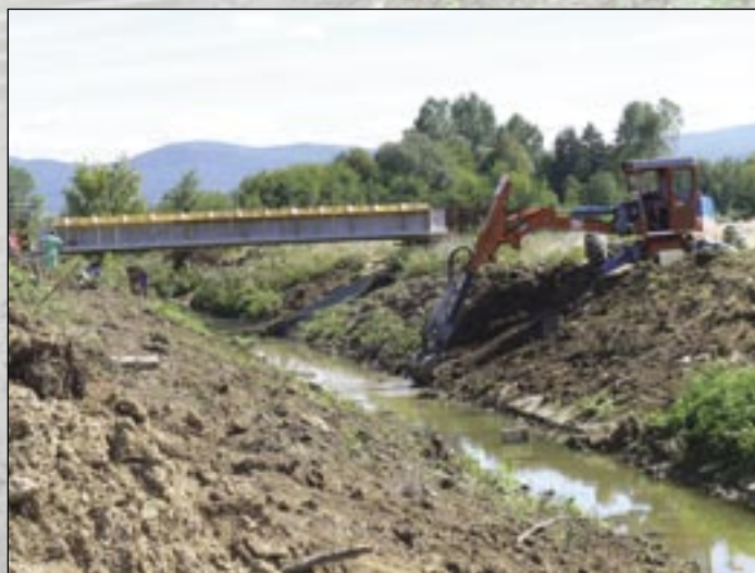
Úprava koryta potoka pri moste 206.
