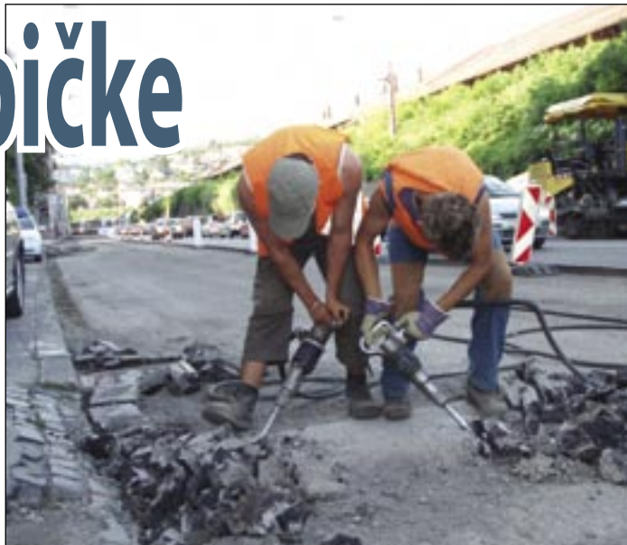
Šramovanie – ručné frézovanie – v plnom prúde. Jaroslav Gerbel (vľavo) a Martin Bartek sa nemali čas ani pozrieť do objektívu.
