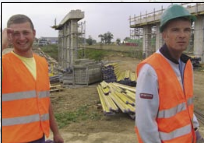
Most 207 preklenie železničnú trať. Na obrázku demontážnici podpornej konštrukcie slúžiacej na realizáciu úložných prahov - vpravo Peter Šramek, vľavo Marek Dubrovaj.
