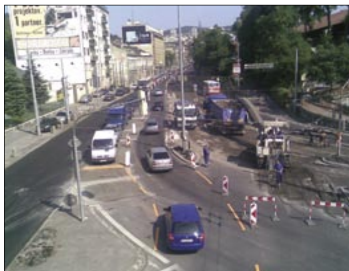
Frézovanie na križovatk Pražská - Šancová pri plnej premávke.
