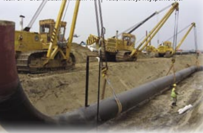
Kladenie veľkorozmerného potrubia sa len tak nevidí.
