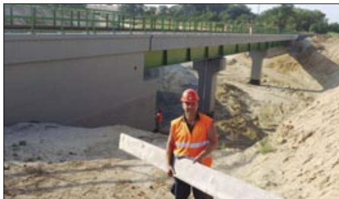
Výsledkem přeložky železniční trati je také nový most. V popředí Jaromír Hanzal.
