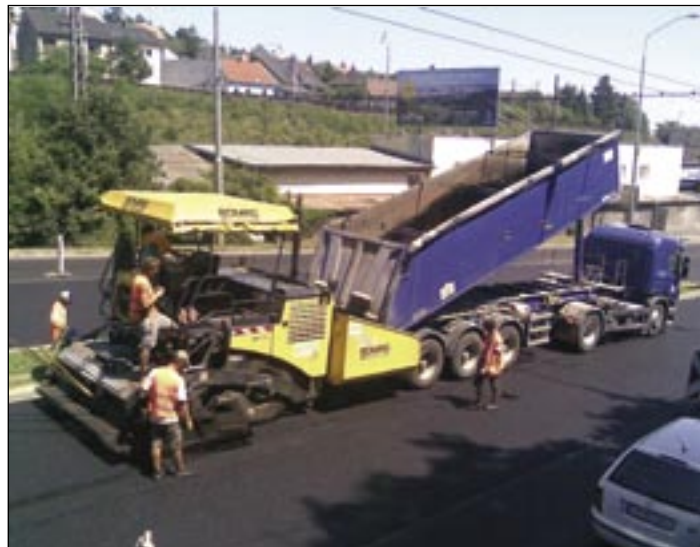
Pokládka zmesi AC 11Pmb na Pražskej ulici.
