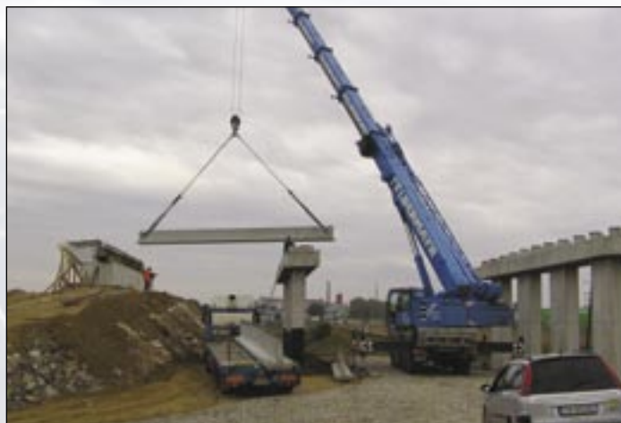
Októbrová pokládka 15-metrových nosníkov mosta 207. Vedúcim bol predák Jozef Kretík.
