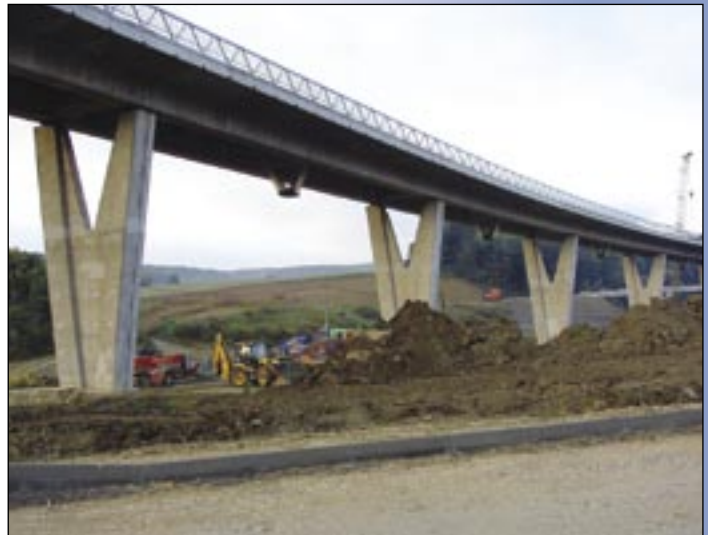
Jedinečný most 215. Deviatori medzi jednotlivými piliermi budú napínať káble, ktoré pribudnú koncom októbra.
