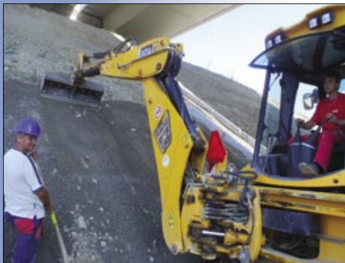
Úprava svahov a kladenie kociek začiatkom jesene. Pracovníci závodu 06 Marján Sochovič (vľavo) a František Jenča.
