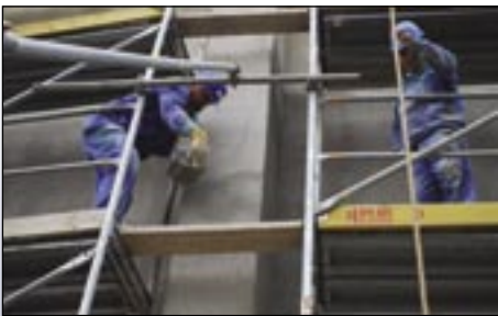
Ľudovít Vereš (vľavo) a Viktor Gála na lešení striekajú steny budovy farebným náterom.
