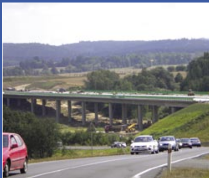
Největší pycha firmy SANGREEN – most SO 201 na rychlostní silnici R6.
