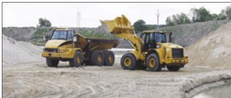
Linka v prevádzke: materiál do dumpera.
