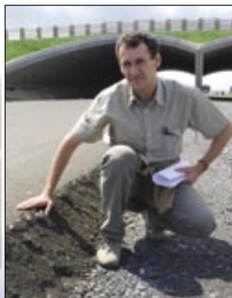
Vrstva mechanicky spevneného kameniva pri ekodukte.
