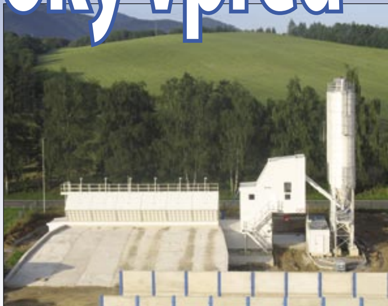
Betonáreň je vedľa obaľovačky, v peknom okolí.
