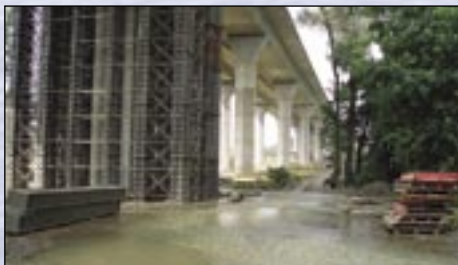
Rozvodnená Luha sa dostala až k mostu 201.
