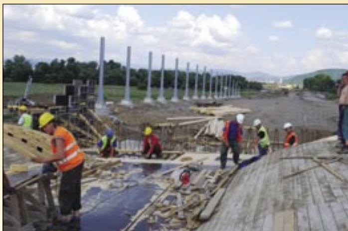
Šalovanie mosta v prvej polovici júna. Vľavo vidieť piliere protihlukovej steny.
