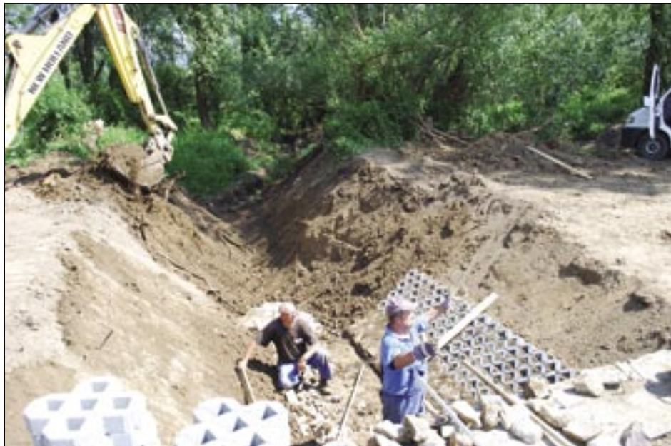
Pracovníci dodávateľskej firmy Káčer kladú zatravnňovacie tvárnice v žľabe neďaleko protipovodňovej hrádze.
