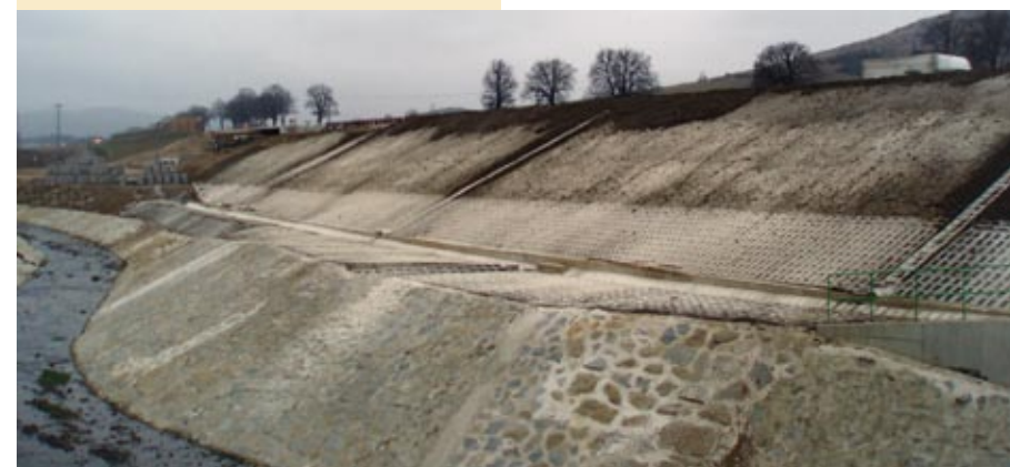
Svah spevnený tvárniciami nad korytom potoka Margecianska.
