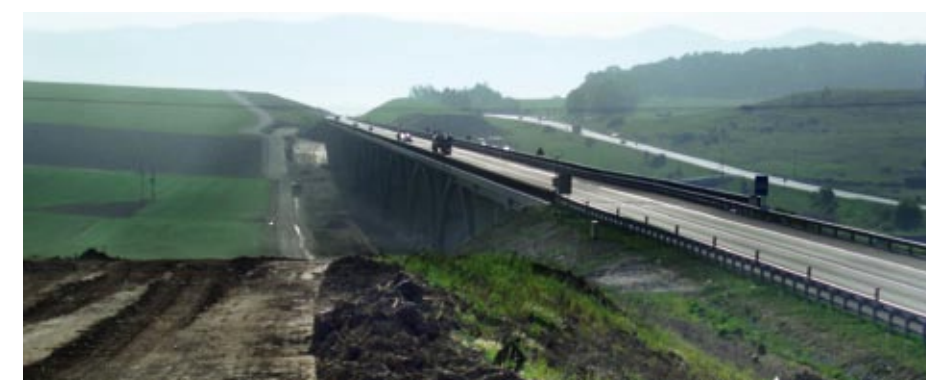
Úvod zemných prác pri oblúkovom moste 205 (stavia Doprastav).
